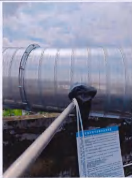
DA002 废气处理前检测口
