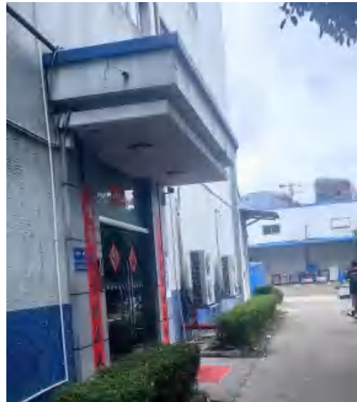
CT 室 (H6 厂房) 北侧
